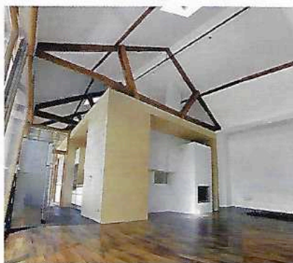
Zwei von Architekt Hans Zeiner umgebaute Vierkanthöfe: Im Bild oben wurde ein alter Getreidespeicher („Troadkasten“) zum Wohngebäude umgestaltet. Die unteren beiden Bilder zeigen das Projekt „Heu“, eine Loftwohnung in einem ehemaligen Heuboden mit frei eingestellter Schlafzimmerbox.
